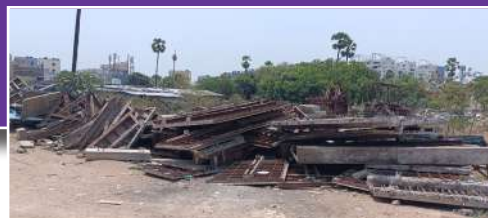
గ్రౌండ్ లోపల నిర్మాణ సంస్థ గిడ్డర్లు, సామగ్రి
