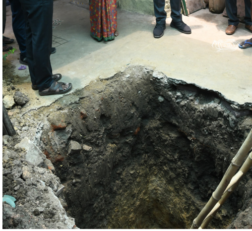
నిర్మాణ పనులు పరిశీలించి అనంతరం కచికంటి గ్రామం లో ఓ ఇంట్లో వ్యక్తిగత ఇంకుడు గుంతల నిర్మాణ పనులు పరిశీలించారు. వ్యక్తిగత ఇంకుడు గుంతలు ఒక ఇంటికి సంబంధించి ఆ ఇంటిలోనే నిర్మించి చిన్న గుంతలు. ఇవి ఇంటి పైకప్పు మీద వదే వర్షపు నీటిని భూమిలోకి ఇంకిపోయేలా చేస్తాయని, ఇంకుడు గుంతలు నిర్మించడం వల్ల భూగర్భ జల మట్టం పెరుగడం తోపాటు బోర్లు ఎండిపోకుండా ఉంటాయని, వర్షపు నీరు వృధా కాకుండా ఉంటుందన్నారు. బోర్లు ఎండిపోకుండా ఇంకుడు గుంతలు నీటి సంరక్షణకు దోహదపడతాయని, పర్యావరణాన్ని కాపాడతాయన్నారు. వ్యక్తిగత ఇంకుడు గుంతలు ఇంటి ఆవరణంలో, బోరు బావికి దగ్గరగా ఇంకుడు గుంతను నిర్మించుకోవాలని భూమి వారు ఉన్న చోట గుంతను నిర్మించడం వల్ల వర్షపు నీరు గుంతలోకి నులభంగా చేరుతుందని, గుంత నిర్మించేటప్పుడు పైన నీరునిల్వకుండా చూసుకోవాలన్నారు. ఇంకుడు గుంతలు కాలక్రమేణా అడుగు పట్టే అవకాశం ఉంటుందికాబట్టి, గుంతలను క్రమం తప్పకుండా శుభ్రం చేయాలని, గుంతల చుట్టూ గడ్డి, చెట్లు పెరగకుండా చూసుకోవాలని సలహాలు సూచనలు చేశారు. ప్రతి ఇంట్లో ఇంకుడు గుంతలు ఏర్పాటు చేసుకోవాలని అన్నారు. తదనంతరం యావల్ గూడ లోని రామాలయం ఆవరణలో SBM నిధులతో నిర్మించిన కమ్యూనిటీ టాయిలెట్ ను పరిశీలించారు. కలెక్టర్ వెంట drdo రవిందర్, ఎంపిడిఓ నాగేశ్వర్ రావు, సిబ్బంది, తదితరులు ఉన్నారు. జిల్లా పౌర సంబంధాల అధికారిణి అదిలాబాద్ గారి చే జారీ చేయవైనది.
